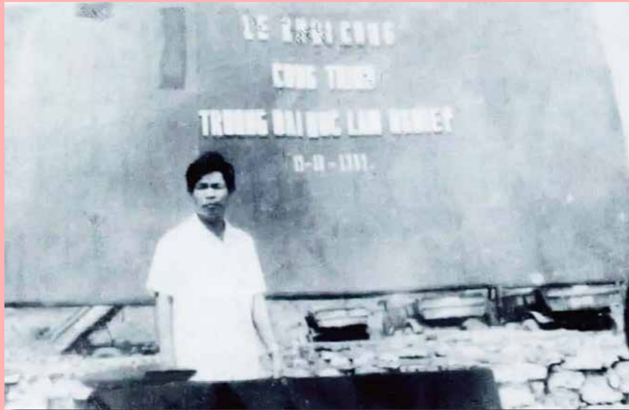
Lễ khởi công xây dựng Trường tại Xuân Mai (12/10/1982)
